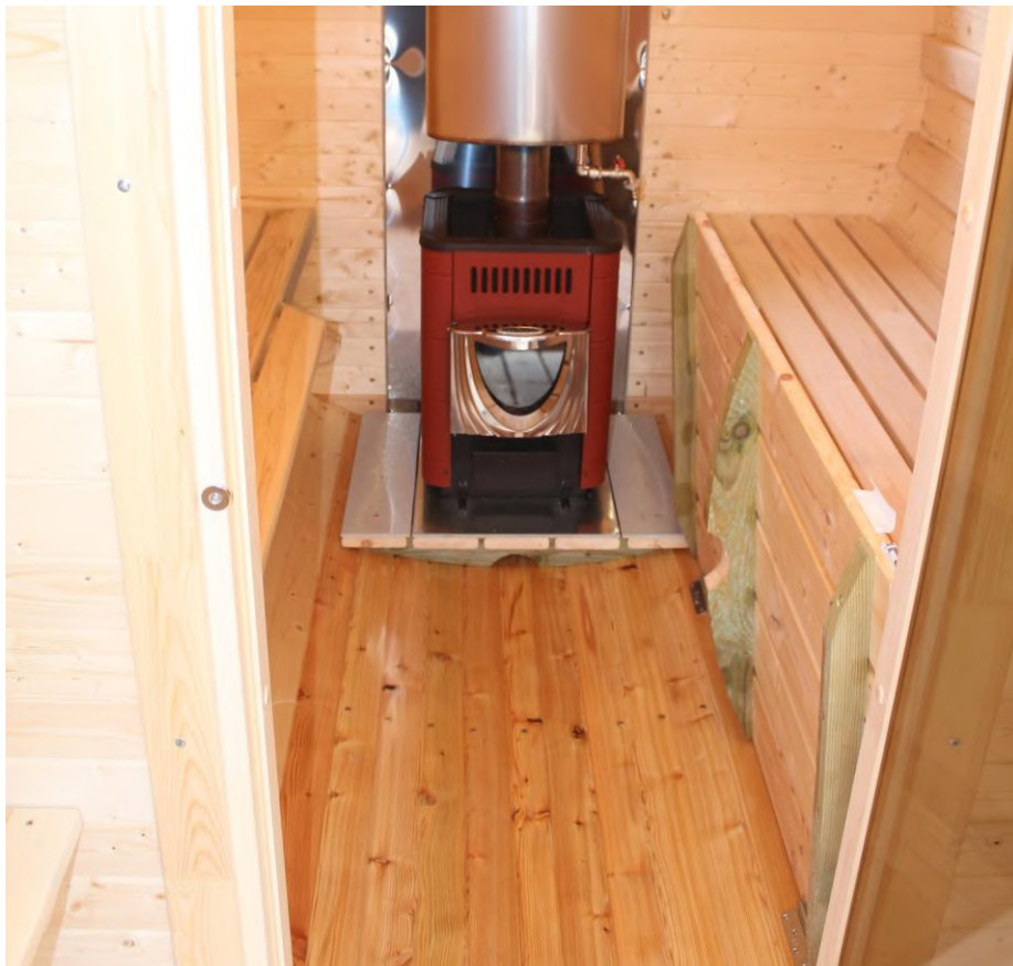
Трапик поднимается на шарнирах для чистки и сушки.
