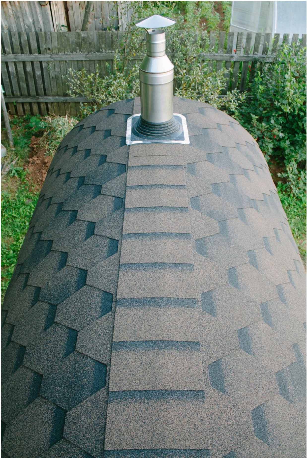
Кровля, вид сверху.
