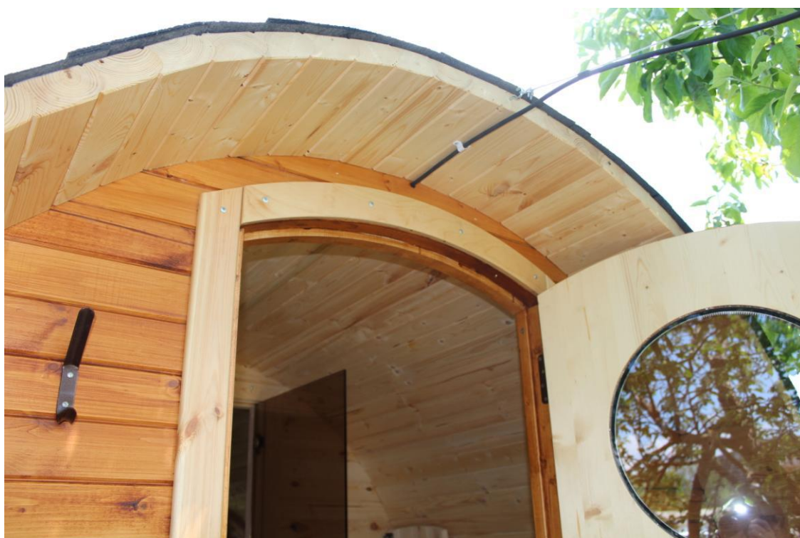
Ввод кабеля в баню
